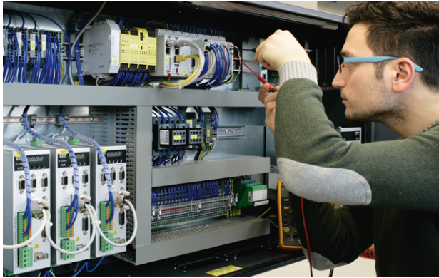
Schaltschrankbau bei Eckelmann
